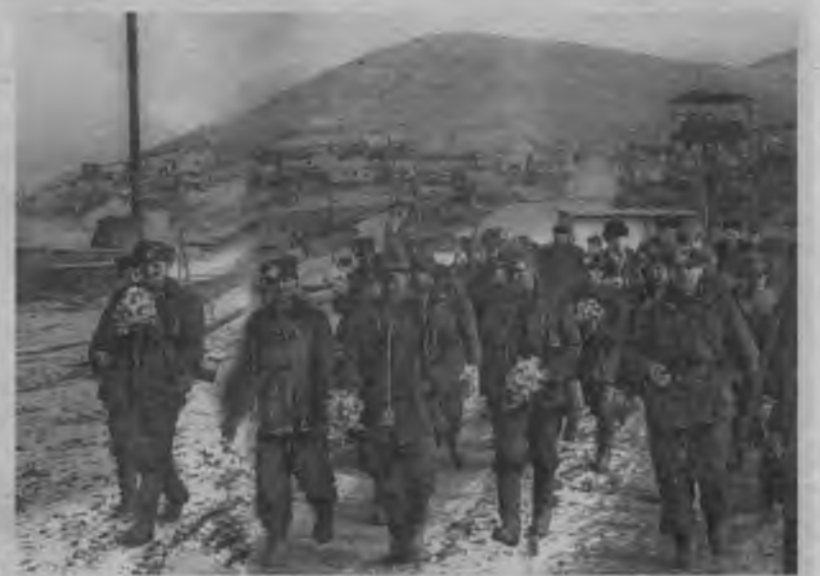
Установлен новый рекорд проходки двухпутевого квершлага, август 1968 г.
